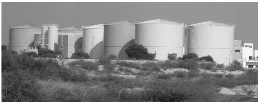
Südlich von Tel Aviv, direkt an der Mittelmeerküste Israels, wurden 13 Flachbodentanks und Spezialbehälter der Abwasserbehandlungsanlage eines großen Chemieunternehmens mit einer aufwändigen Innenbeschichtung versehen.
